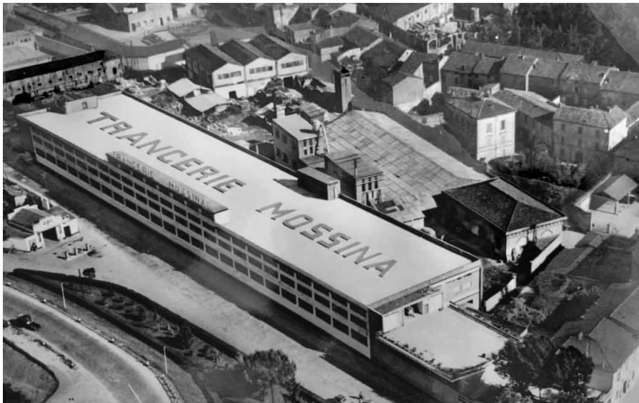
Stabilimento in Via Circonvallazione
